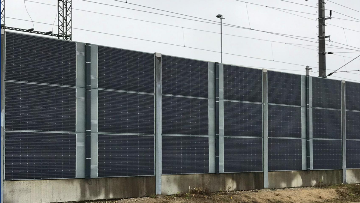
ÖBB-DAS -Energy - LÄRMSCHUTZWAND
